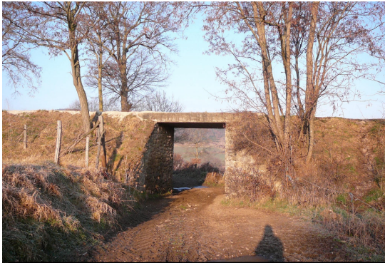
Tous les ponts supérieurs à la route et aux cours d'eau ont un tablier en béton qui n'est pas d'origine. Nul doute qu'il devait être auparavant en métal puis retiré pour être ferrailé.
